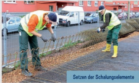
Einfacher Transport der Baumaterialien
